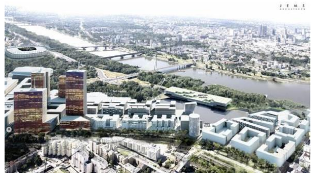
Fig. 7. Design of "Port Praga" from 2011. Source: architectural office JEMS Architekci, www.jems.pl Ryc. 7. Projekt „Portu Praskiego” z 2011 roku, źródło: biuro architektoniczne JEMS Architekci www.jems.pl
