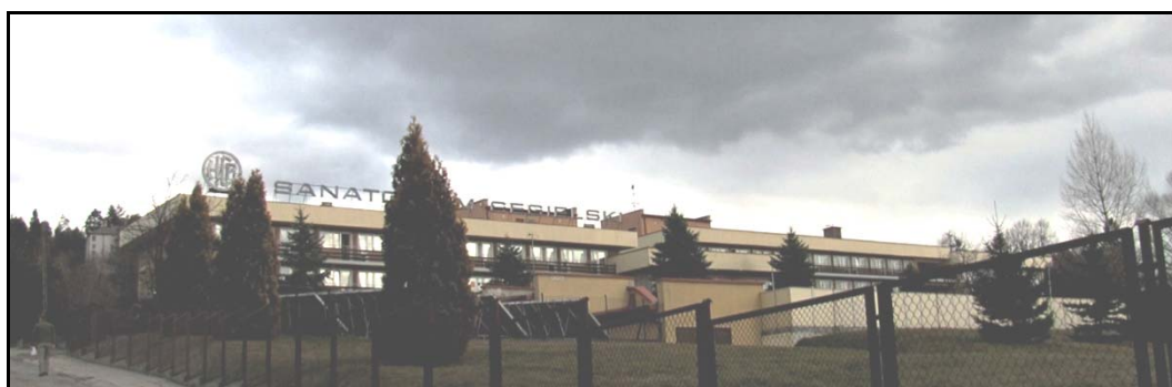
Ryc. 6. Sanatorium Cegielski – elewacja południowa Źródło: il. E. Romaniak
