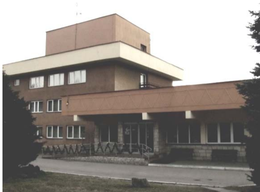
Ryc. 3. Sanatorium Cegielski – strefa wejściowa, frag. elewacji północnej. Źródło: il. E. Romaniak
