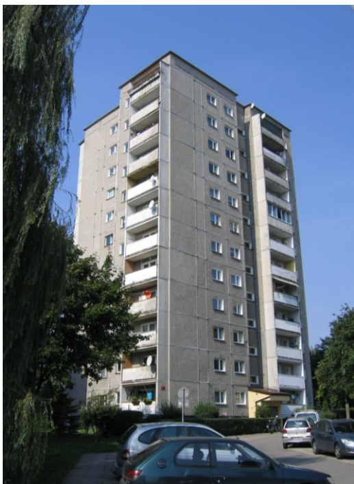
Ryc. 3. Budynek przy ul. Lipińskiego w Krakowie wyłoniony do konkursu „Odśwież swój blok” - wygląd oryginalny. Źródło: fot. J. Tarajko-Kowalska
