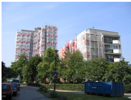
Ryc. 2. Bloki z wielkiej płyty w trakcie termomodernizacji - Kraków. Źródło: fot. J. Tarajko-Kowalska
