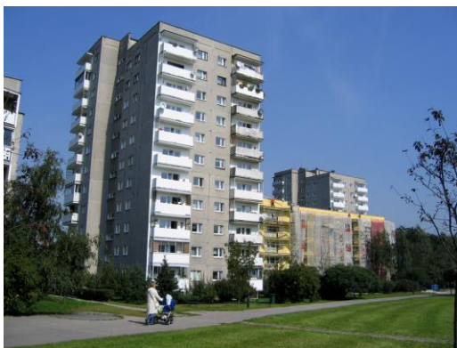
Ryc. 1. Typowe, nieotynkowane budynki z wielkiej płyty na jednym z krakowskich osiedli. Źródło: fot. J. Tarajko-Kowalska
