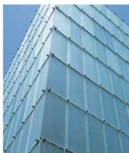
Ryc.6. Muzeum Sztuki Współczesnej, Bregenz, Austria. Arch. Peter Zumthor Zewnętrzna warstwa szklenia. Źródło: www.archiweb.cz
