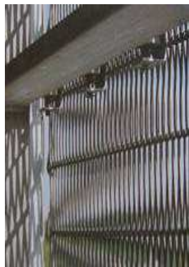
Ryc.13. Francuska Biblioteka Narodowa, Paryż. Arch. Dominique Perrault. Fragment metalowej siatki zawieszony przed oknami. Źródło: Detail , nr 2/1999r.
