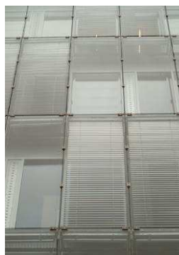
Ryc.3. Siedziba PLL LOT, Warszawa. Arch. Kuryłowicz & Associates. Żaluzje na elewacji. Źródło: Mat. własne. Fot. M. Mateńko.
