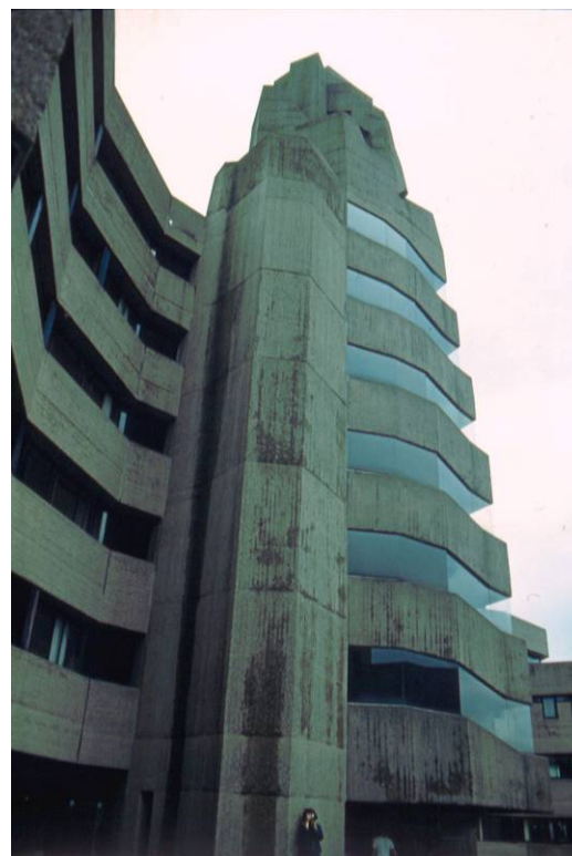
Il. 2. Bensberg – fragment nowej struktury z betonową wieżą, pełniącą funkcję klatki schodowej w ratuszu. Źródło: fot. autora
