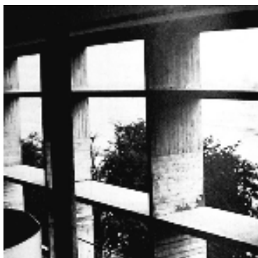
Il. 15. Betonowe brise-soleil; proj. Le Corbusier. Źródło: Boesinger W., Girsberger H. , „ Le Corbusier 1910-65 ”, Artemis, Zurich 1967.
