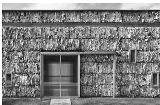
Fig. 4. Fot: Tomas Riehle / arturimage Ryc. 4. Fot: Tomas Riehle źródło: dost: 19.10.20 www.archirama.muratorplus.pl
