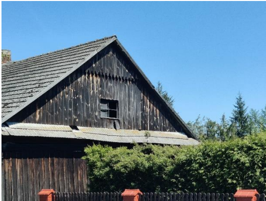
Fig. 2. Arrangement of boards on the gable wall, boards arranged vertically with an overlap, ornament in the upper layer, house in Niedźwiadzia Dolna near Ropczyce; Subcarpathia, Poland; Source: author's photo Ryc. 2. Układ desek na ścianie szczytowej, deski układane pionowo na zakładkę, ornament w górnej warstwie, dom w Niedźwiadzie Dolnej k. Ropczyc; woj. Podkarpackie, Polska; Źródło: Fot. Autora
