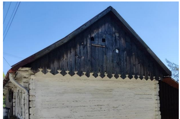
Fig. 5. Vertical arrangement of boards on the gable wall, ornament at the end of boards, house in Ropczyce, Subcarpathia, Poland; Source: author's photo Ryc. 5. Pionowy układ desek na ścianie szczytowej, ornament na zakończeniu desek, dom w Ropczycach, woj. Podkarpackie, Polska; Źródło: Fot. Autora
