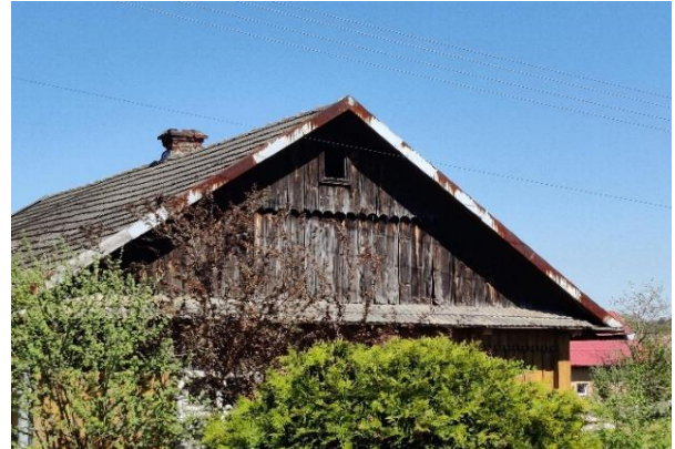
Fig. 3. Arrangement of boards on the gable wall, boards arranged vertically with an overlap, ornament in the upper layer, house in Krzywa near Sędziszów Młp.; Subcarpathia, Poland; Source: author's photo Ryc. 3. Układ desek na ścianie szczytowej, deski układane pionowo na zakładkę, ornament w górnej warstwie, dom w Krzywej k. Sędziszowa Młp.; woj. Podkarpackie, Polska; Źródło: Fot. Autora
